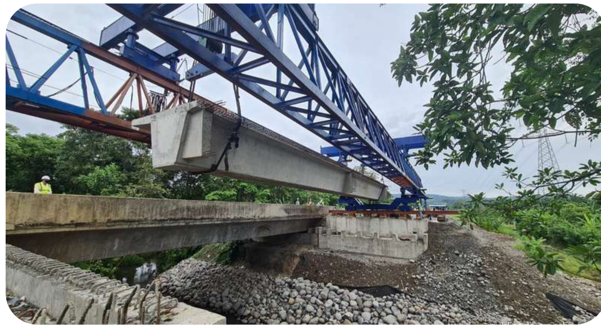
Imagen de la construcción del nuevo puente sobre el río Cuba, en la ruta 32.
